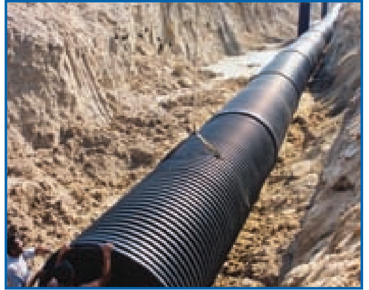
Resim 6.1.1- Avrupa Serbest Bölgesi'nde kanalizasyon uygulamasından görüntü.
