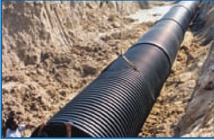
Resim 6.5.2.b - Avrupa Serbest Bölgesi'nde kanalizasyon uygulamasından görüntü.
