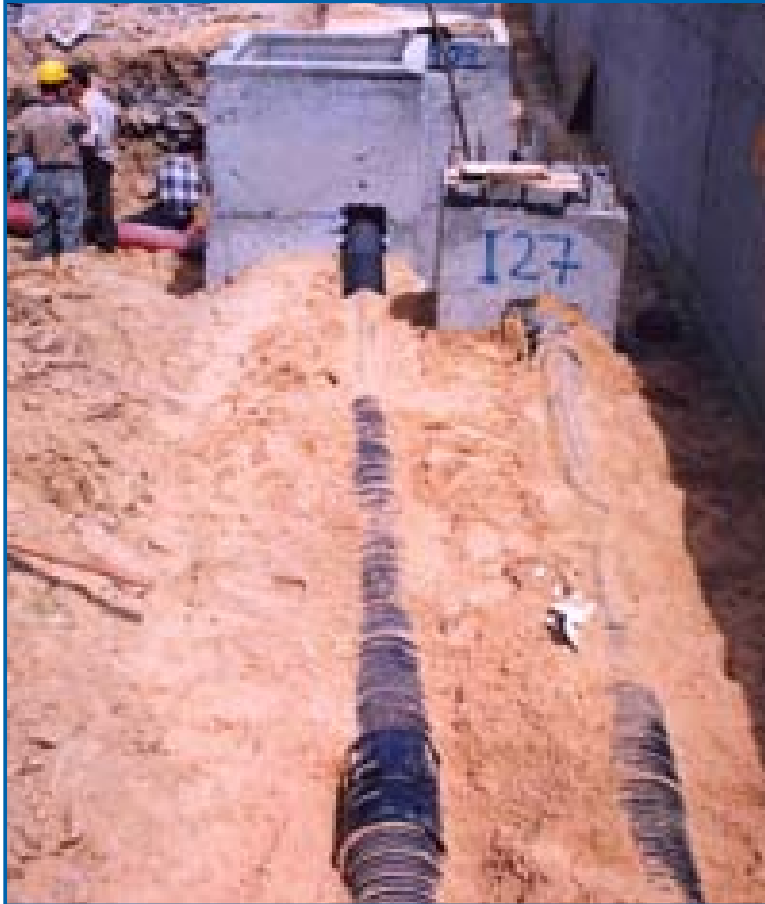
Resim 6.5.1- İş Bankası Genel Müdürlük Binalarının Alt Yapısını Gösteren Korige Boru Uygulama Resimleri
