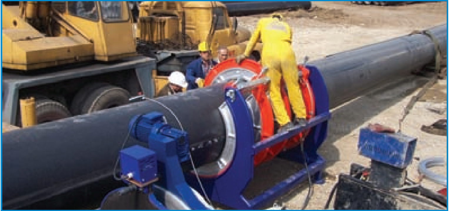
Resim 2.5.1 Şantiyede alın kaynağı uygulaması.
