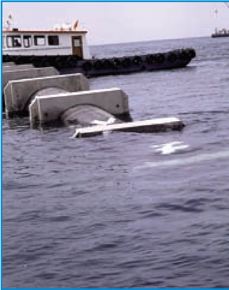
Resim 2.1.10 - Büyükçekmece deniz deşarjı için üretilen Ø 1600 mm PN4 borunun görünümü
