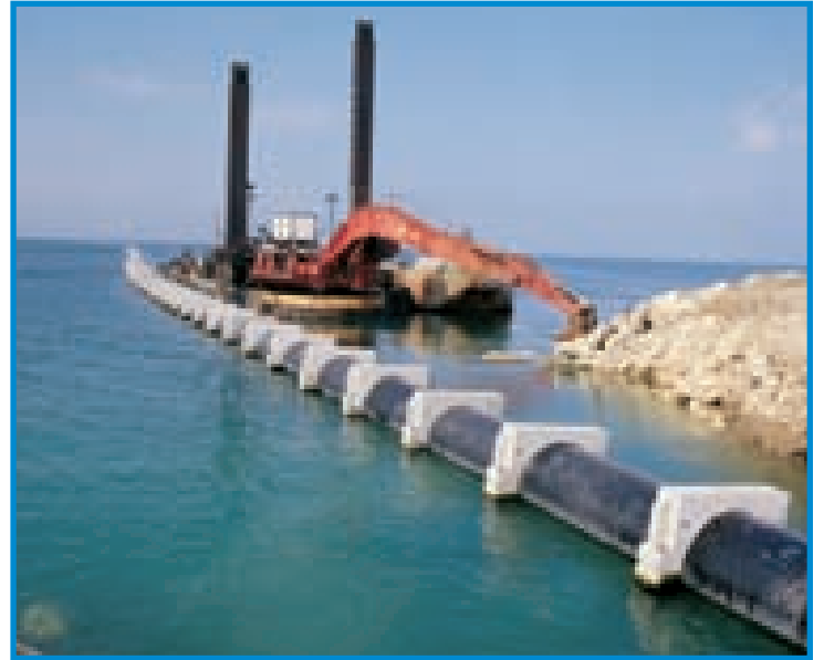
Resim 2.1.7b - İstanbul-Büyükkçekmece deniz deşarjı uygulması (Ø 1600 PN4 boru)
