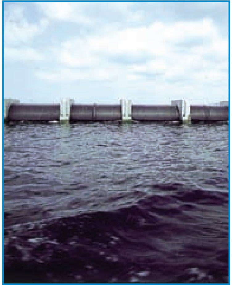
Resim 2.1.10 - Büyükçekmece deniz deşarjı için üretilen Ø 1600 mm PN4 borunun görünümü
