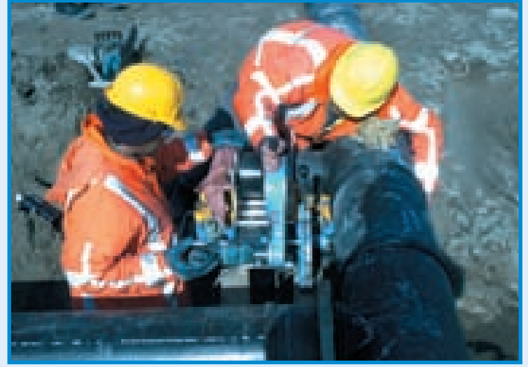
Resim 2.2.1- Alın kaynak uygulamasından bir görüntü
