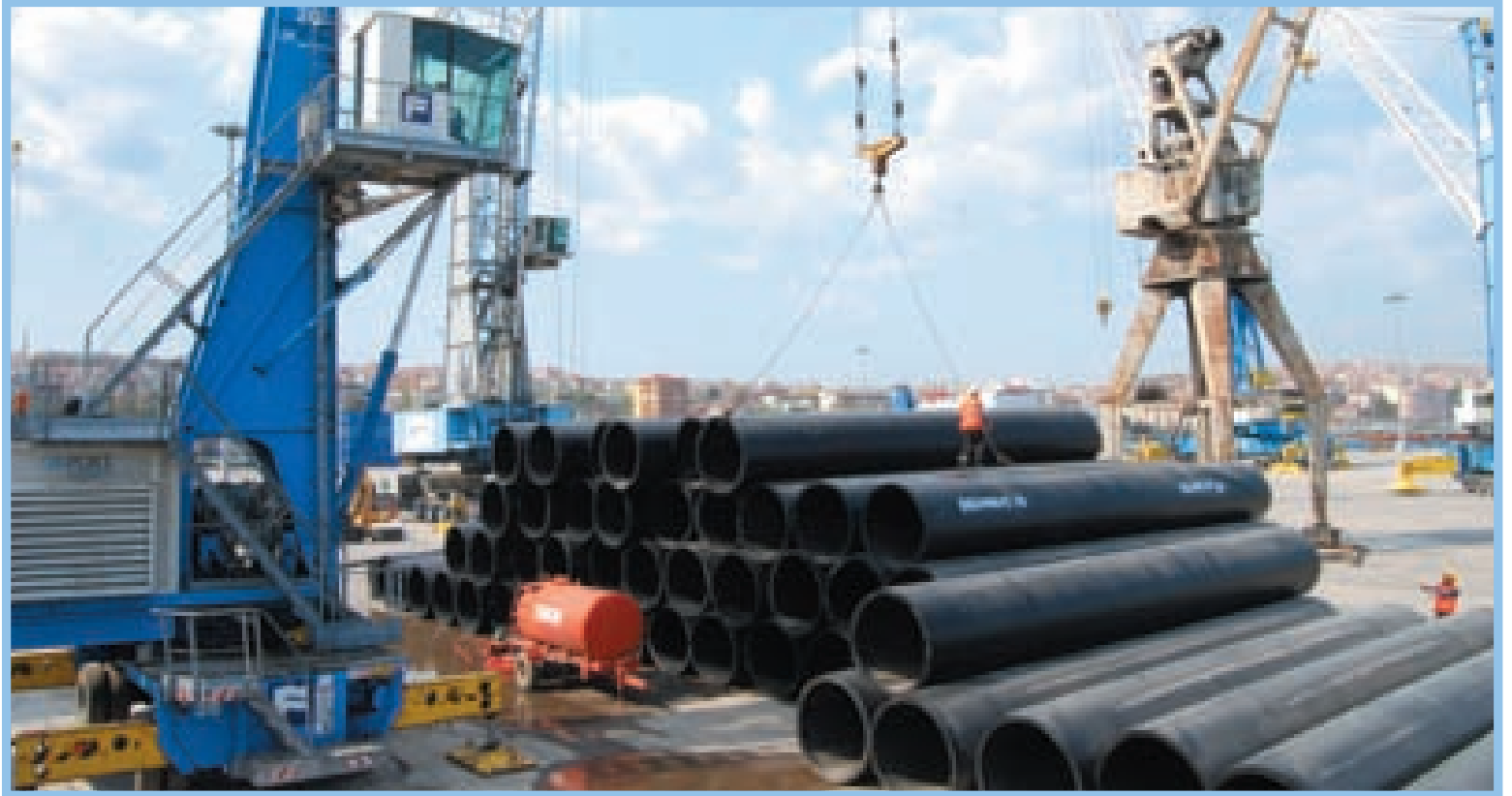
Resim 2.4.2. Santo Domingo temizsu projesi için üretilen 1600 mm PE100 basınçlı borular
