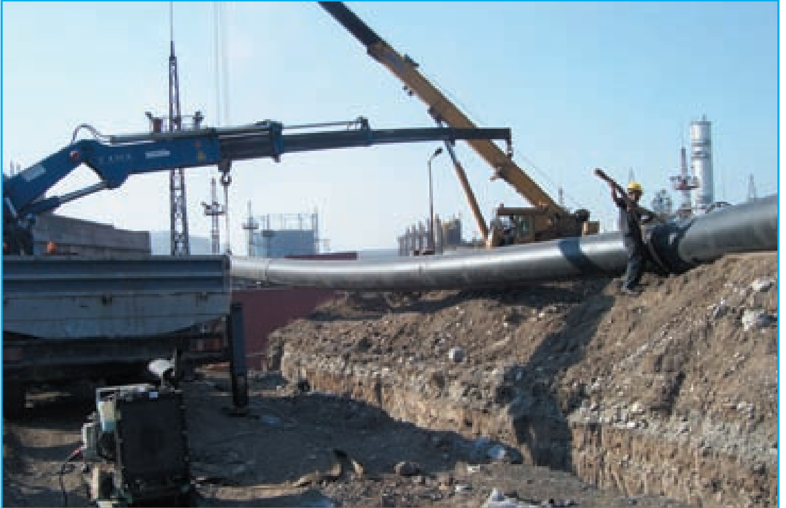
Resim 2.1.6 - Hendeğin dışında boru birleştirme ve hendeğe yerleştirme uygulaması
